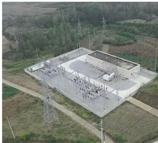
平顶山鲁山鑫丰牛心山分散式风电场 35 千伏送出工程 场地硬化
