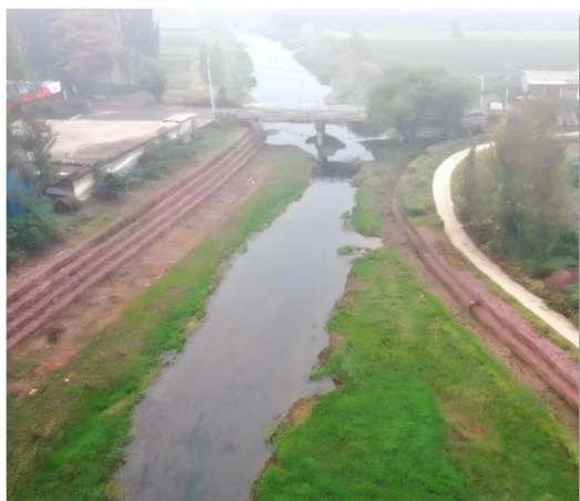
郑县水系连通及水美乡村建设试点县项目 道路两侧护岸
