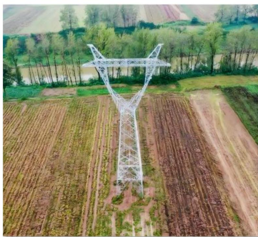
平顶山舞钢森海 220 千伏输变电工程 塔基复耕
