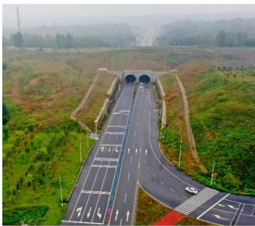
新增 G345（原 S331）舞钢段改建工程 道路两侧护岸
