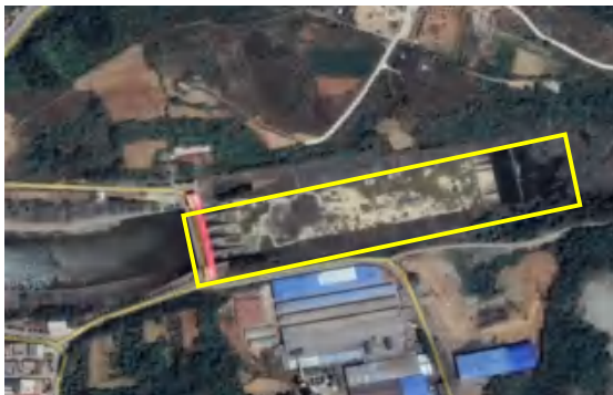
尧沟溢洪道（拟拆除重建）
