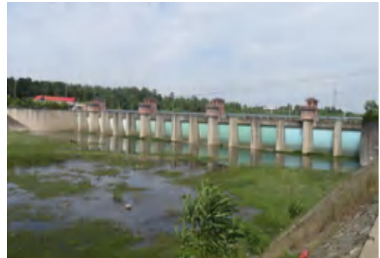
杨家岭非常溢洪道（拟改建混凝土坝）
